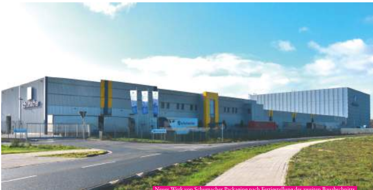
Neues Werk von Schumacher Packaging nach Fertigstellung des zweiten Bauabschnitts
